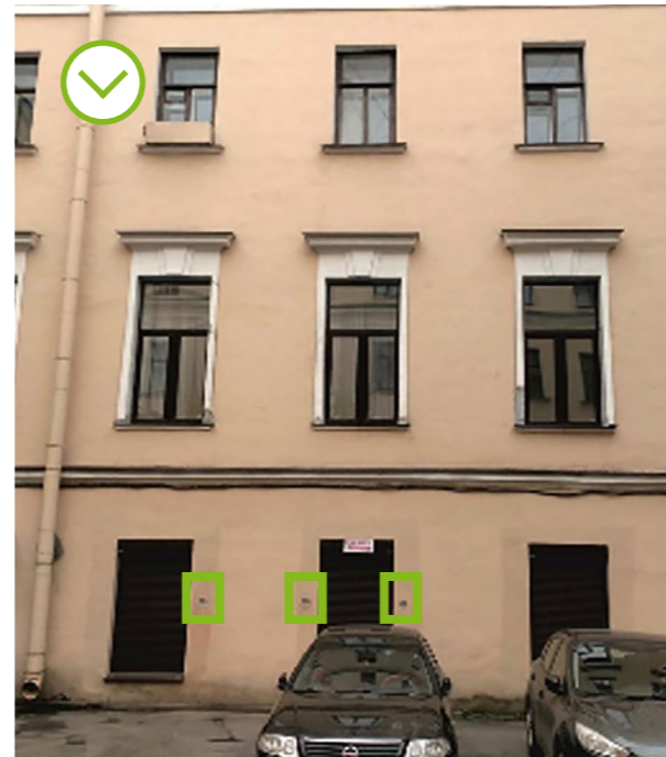
ВЕНТИЛЯЦИОННЫЕ РЕШЕТКИ ДИАМЕТРОМ НЕ БОЛЕЕ 20 СМ
